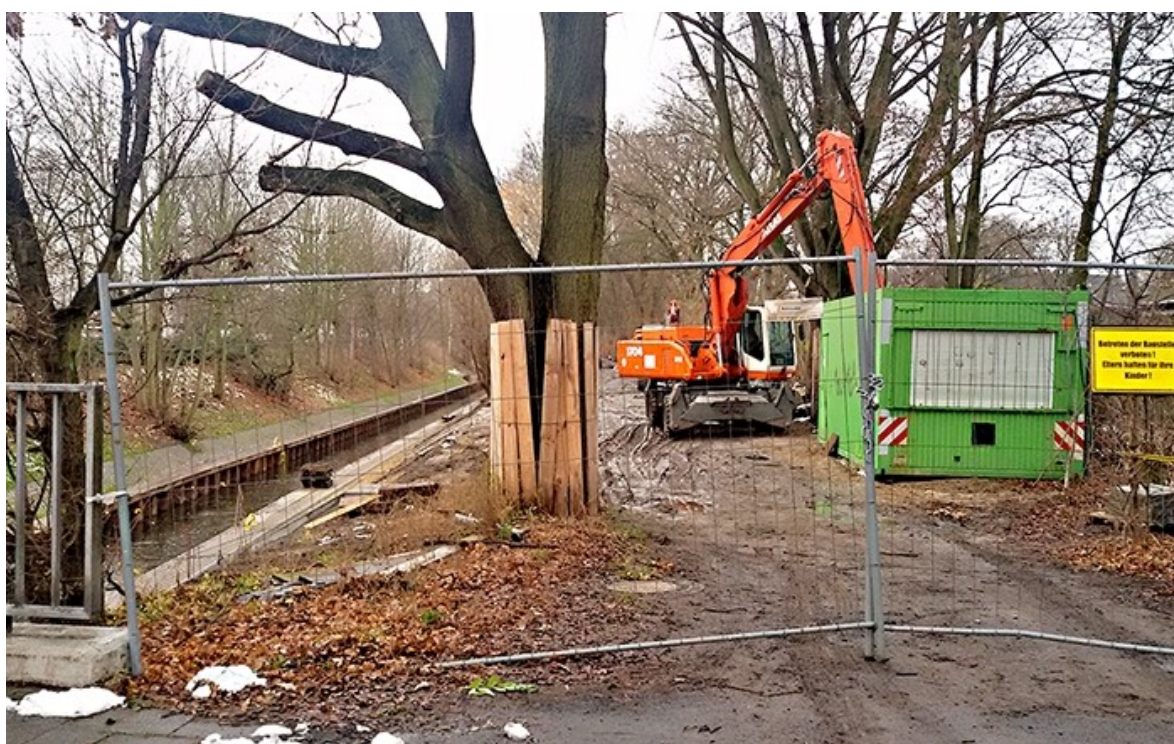
Baustelle Nordgraben/Schorfheidestraße Mitte Dezember Foto: mfk
