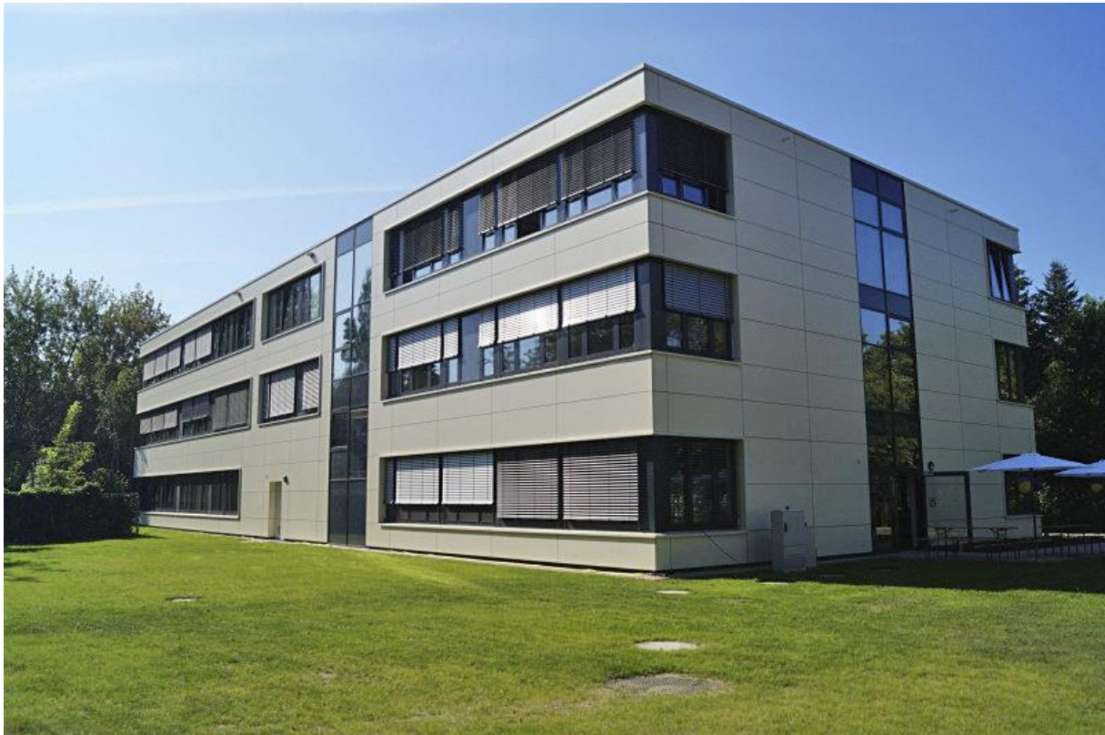
Der Modulare Ergänzungsbau an der Schule am Park (Bild: promo)
